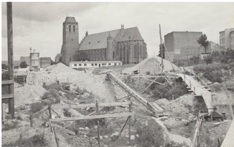
→ Budowa osiedla Stare Miasto
